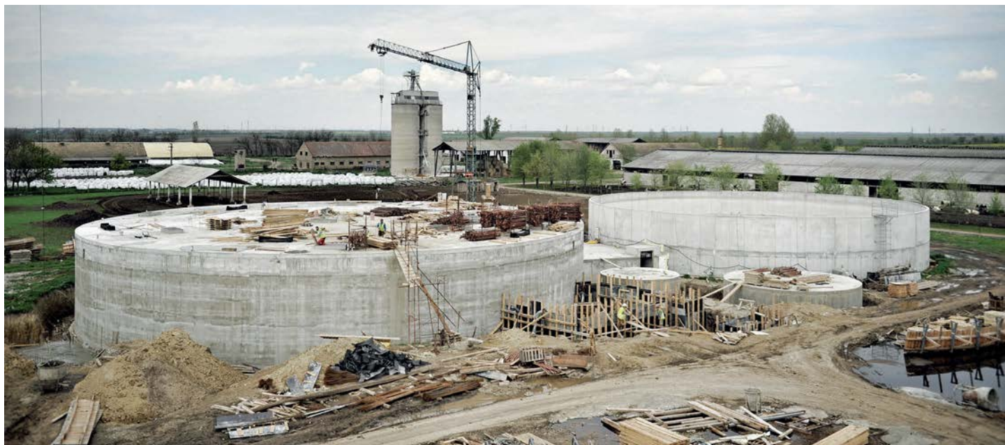
"MIROTIN SAVA KOVAČEVIĆ": Izgradnja biogasnog postrojenja
