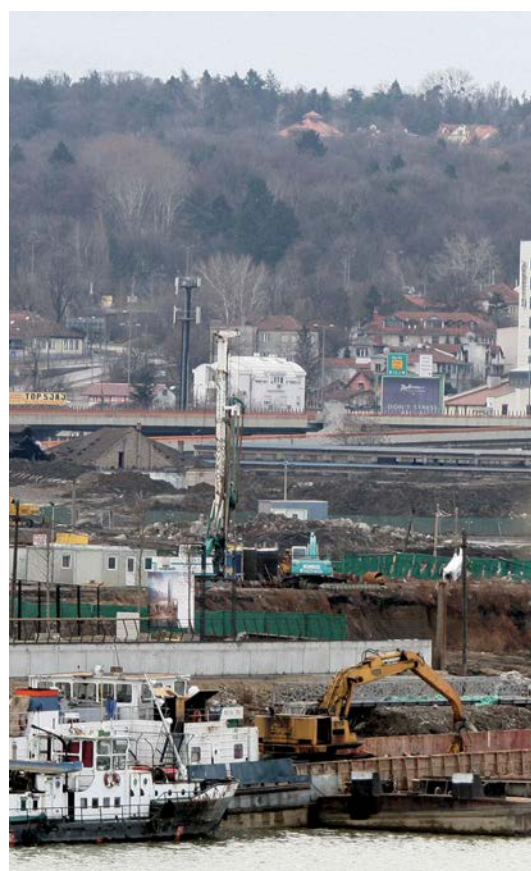
DEMINIRANJE: Izgradnja "Beograda na vodi" Foto: Sava Radovanović / Tanjug
