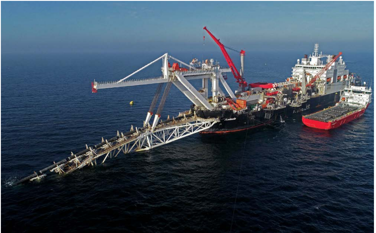
IZ RUSIJE ZA EVROPU, SA SVIH STRANA: Izgradnja gasovoda Severni tok u Baltičkom moru Fotografije: AP/DPA
